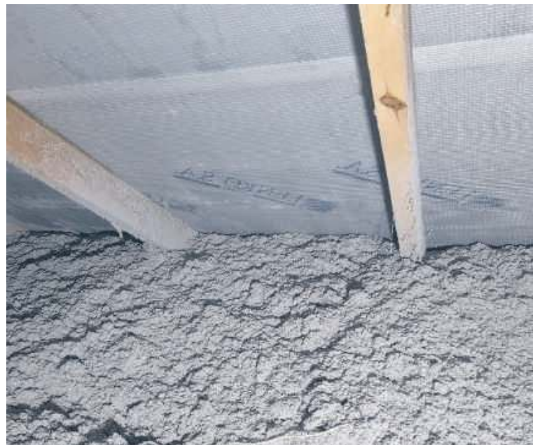
Przed... i po dociepleniu wełną celulozową
