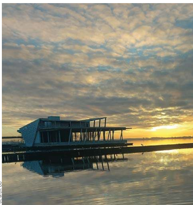
Niedokończona budowa restauracji na miejskiej plaży
