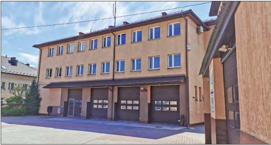
■ Gmina Ryki nieodpłatnie przekazała swoją działkę przy ulicy Lubelskiej pod budowę nowej straży. Zamyśl był taki, aby w ramach rekompensaty samorząd „przejął” budynek przy Warszawskiej i tak się ostatecznie stało. Gmina kupiła wartą ponad 2 mln zł nieruchomość z 99% bonifikatą czyli za ok. 22 tys. zł
