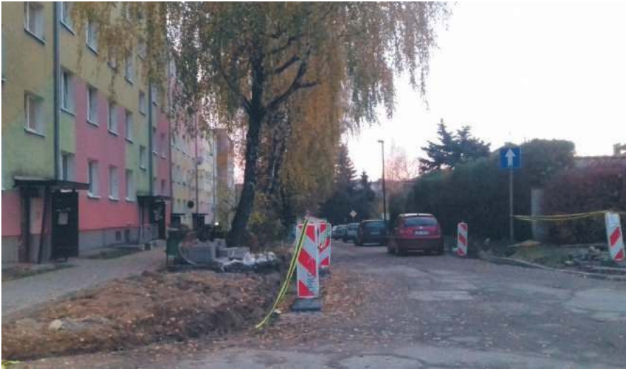
Po remoncie ulicą Czereśniową rowerzyści będą mogli jeździć w obu kierunkach
