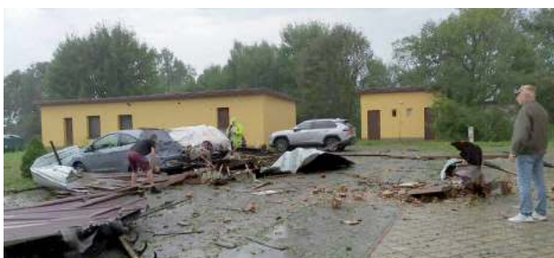
Fragment dachu z budynku Zakładu Opiekuńczo-Leczniczego w Tulnikach uderzył w zaparkowane auta pracowników
