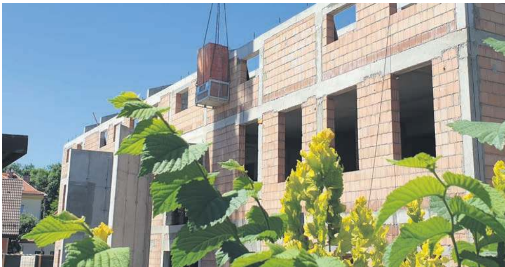
Budynek ma już dwa piętra
