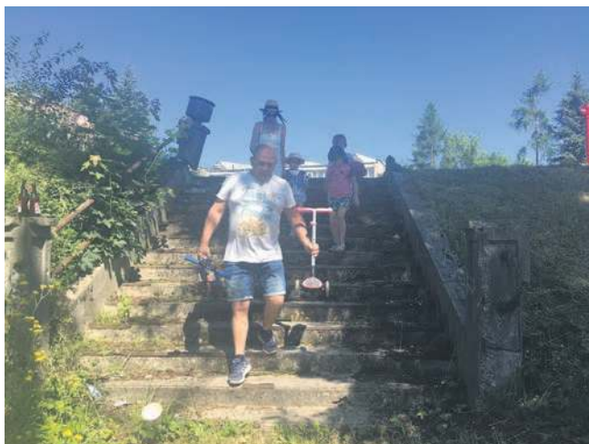
Do głównej drogi można dojść od budynku wspólnoty albo zniszczoną drogą, albo zdezelowanymi schodami
