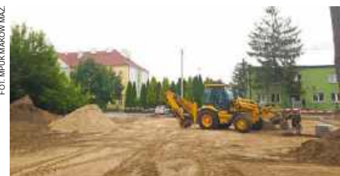
Prace zakończą się przed rozpoczęciem roku szkolnego
