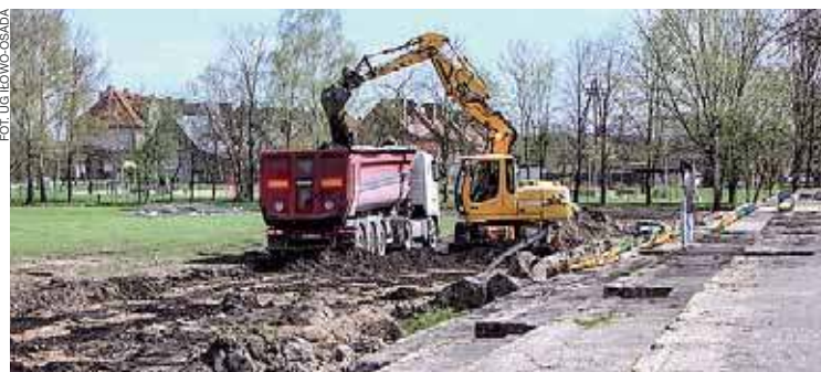
Aktualnie trwa rozbiórka obiektu
