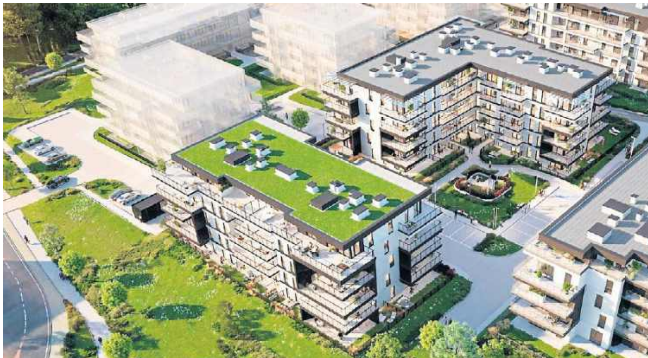
Osiedle Bella Vista - nowoczesne budynki z balkonami i garażami przy ulicy Generała Andersa
