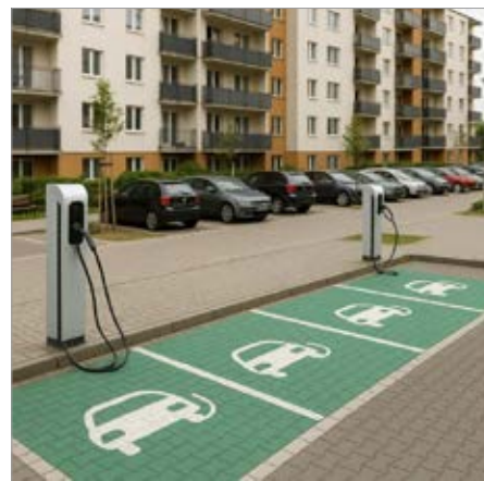
Ładowarki na osiedlu mieszkaniowym to wciąż rzadki widok w naszym kraju fot. emobilnosc.com
