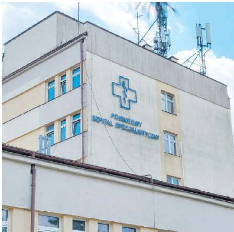
W wyremontowanych pomieszczeniach ma zostać ulokowana neurochirurgia
