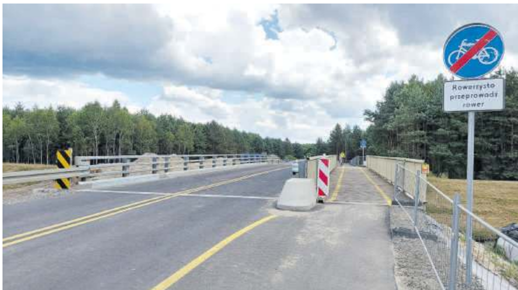
W trakcie realizacji inwestycji kierowcy, piesi i rowerzyści korzystają z mostu tymczasowego
