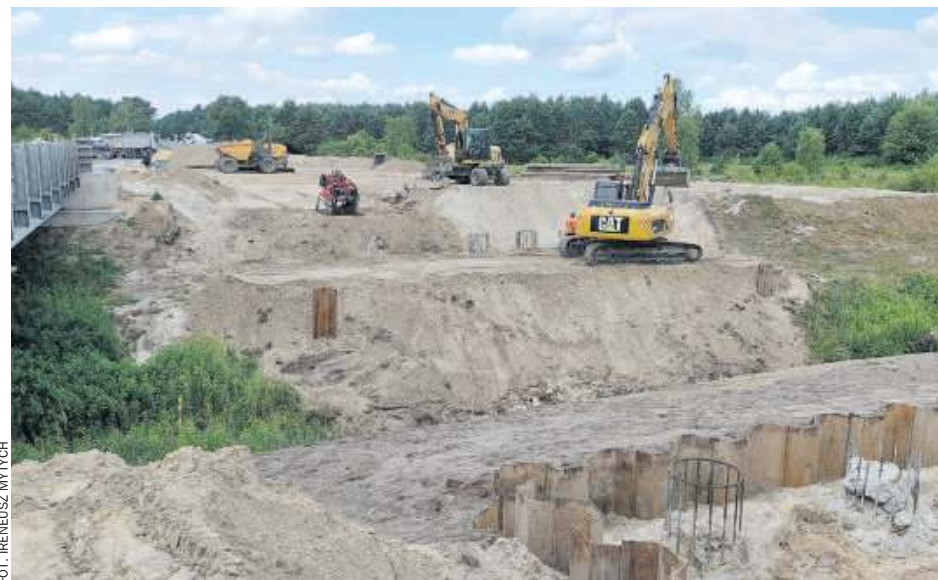
Niebawem nad Jodłówką ma się pojawić nowa przeprawa mostowa
