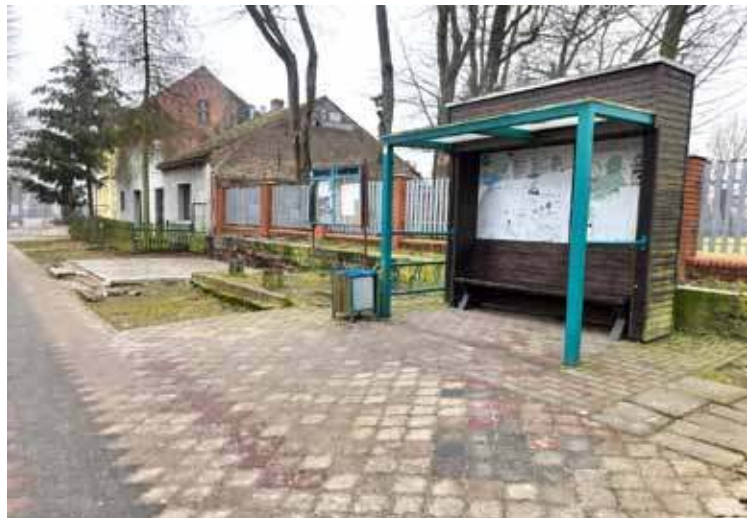
Rozpoczęły się prace związane z rewitalizacją centrum Dolic. Rozbierane są pawilony stojące przed Gminnym Centrum Kultury
