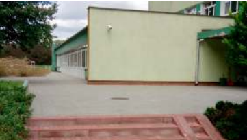
Nowe płytki zastąpiły stary popękany, kruszący się beton
