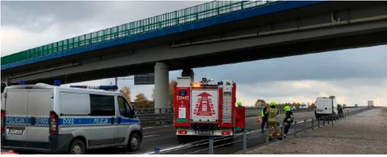
Do tragedii doszło na jednym z wiaduktów nad drogą ekspresową S-19 w pobliżu Konopnicy
