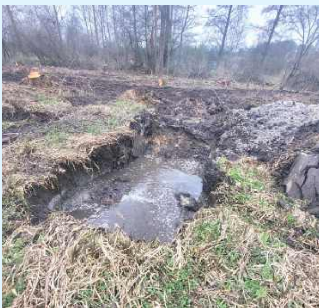
Już próbny wykop w Szczepieszynie odsłonił wodę. W tym miejscu ma powstać zbiornik retencyjny
