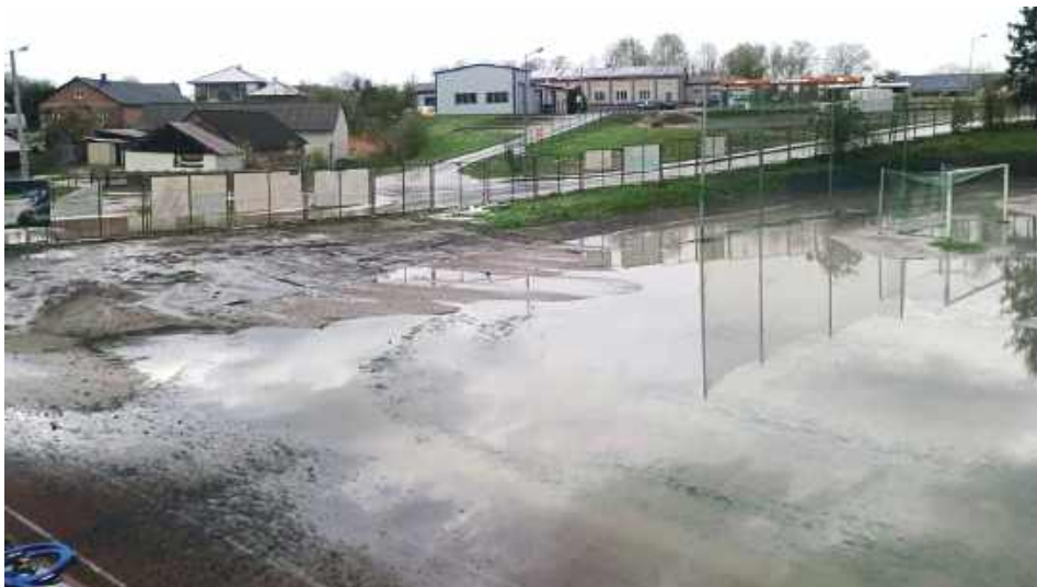
Woda zniszczyła boisko na stadionie w Tarnogrodzie
