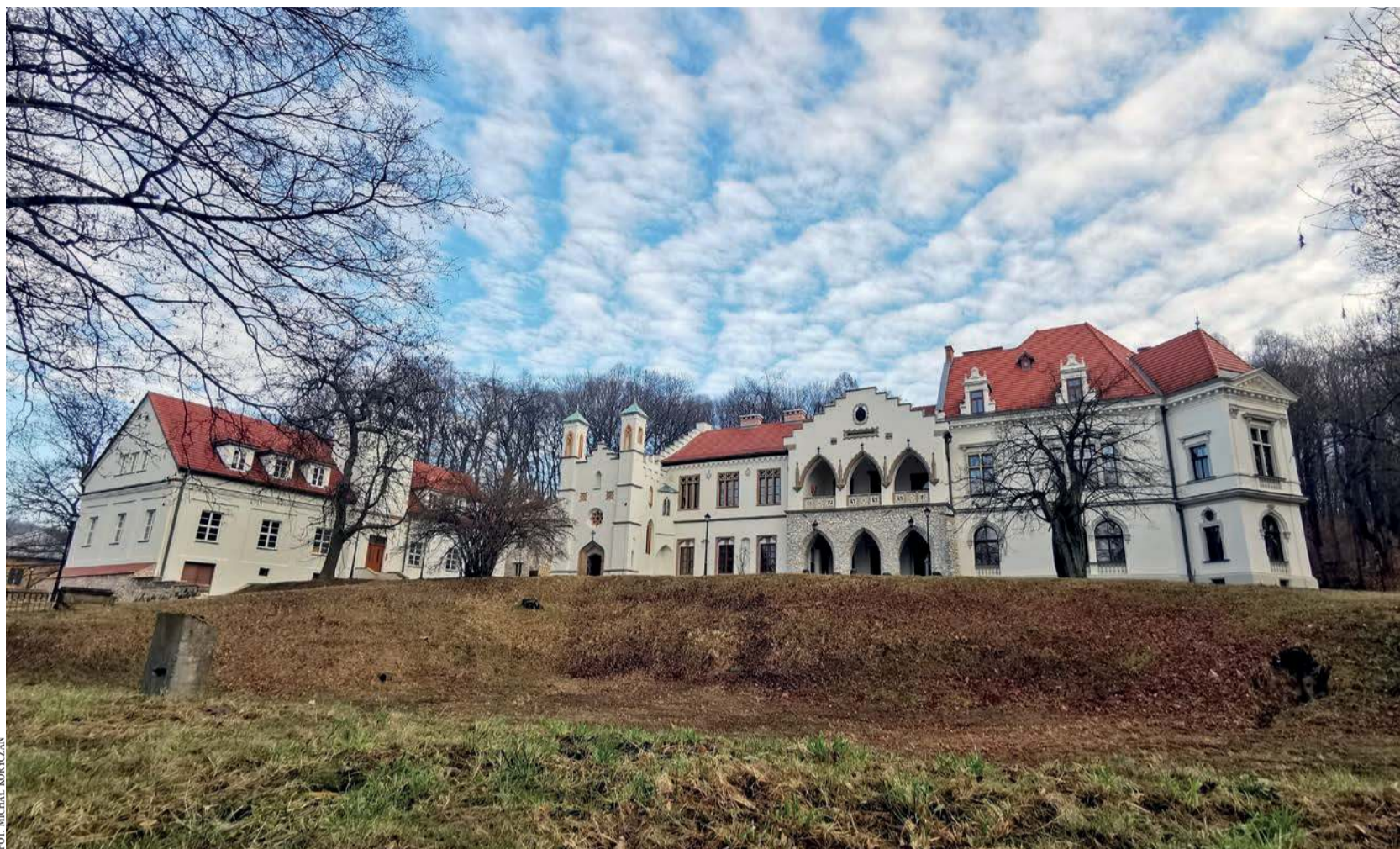
Pałac i oficyna zegarowa z odnowioną elewacją
