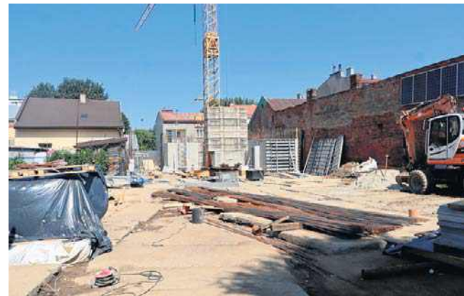
Ruszyła budowa bloku przy Kościuszki 13 w Gorlicach, a kolejne inwestycje SIM Małopolska czekają na start
