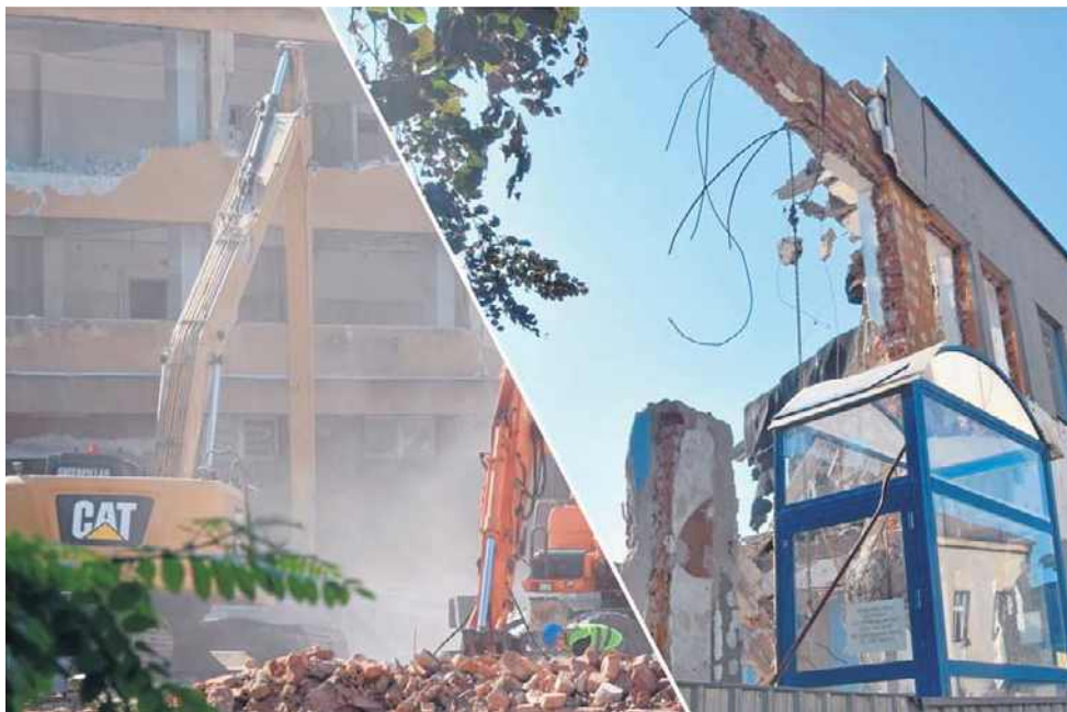
Trwa rozbiórka budynków pomiędzy ulicami Ochronek i Garbarską w Tarnowie
