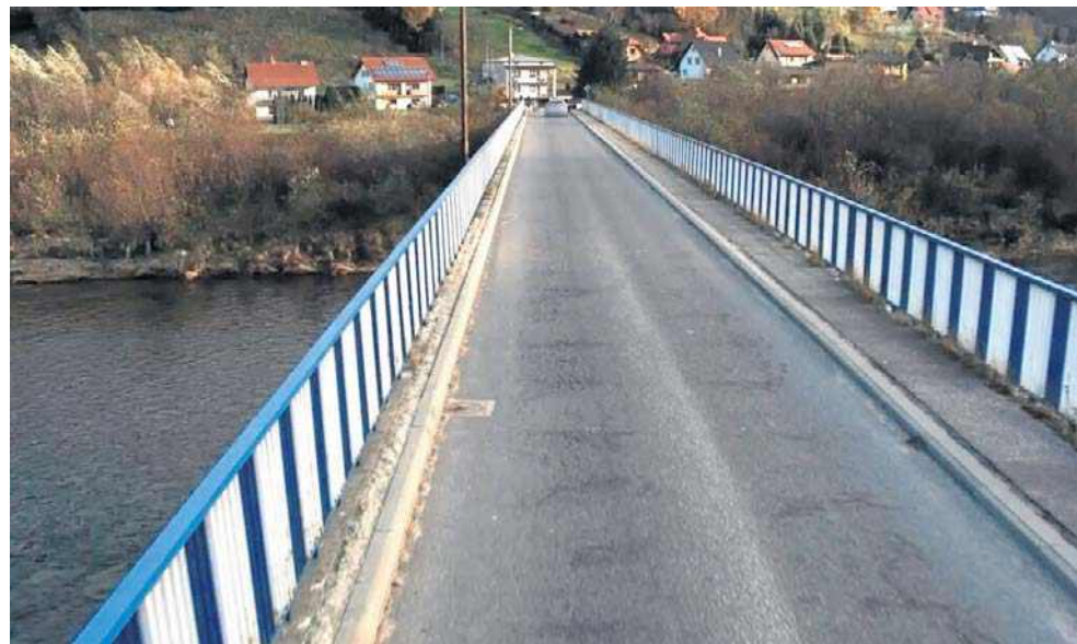
Jednopasmowy most prowadzący do zamku w Rytrze niedługo zastąpi nowa przeprawa
