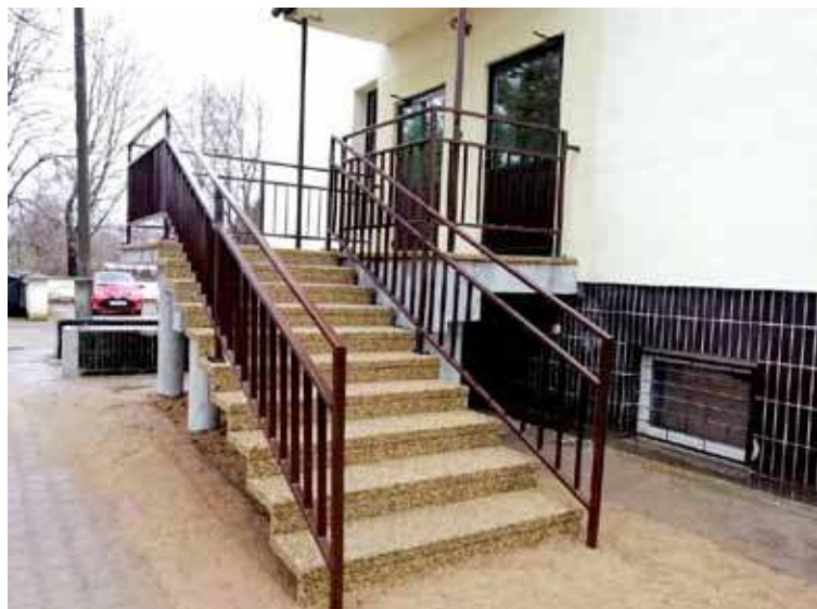
Zakończył się remont parteru budynku Domu Pomocy Społecznej
