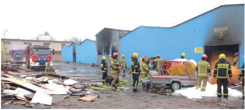
Całkowitemu zniszczeniu uległa południowo-wschodnia część hali. Straty oszacowano wstępnie na 5 mln zł
