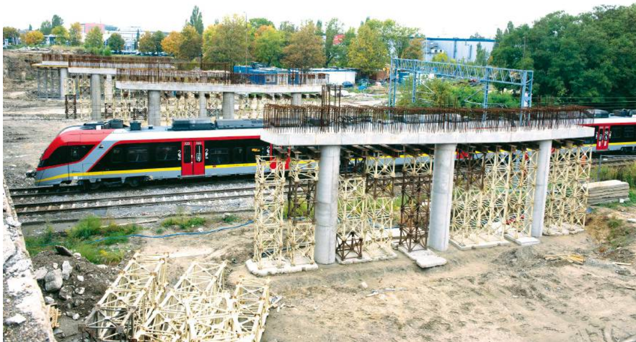
Przebudowa wiaduktów przy ul. Przybyszewskiego w Łodzi.
