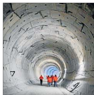
Budowa tunelu średnicowego została przerwana półtora roku temu. Kto i kiedy ją dokończy?
