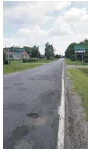
W tym roku zostanie wykonany remont odcinka drogi na trasie Dobratycze – Kostomłoty o długości 9,896km
