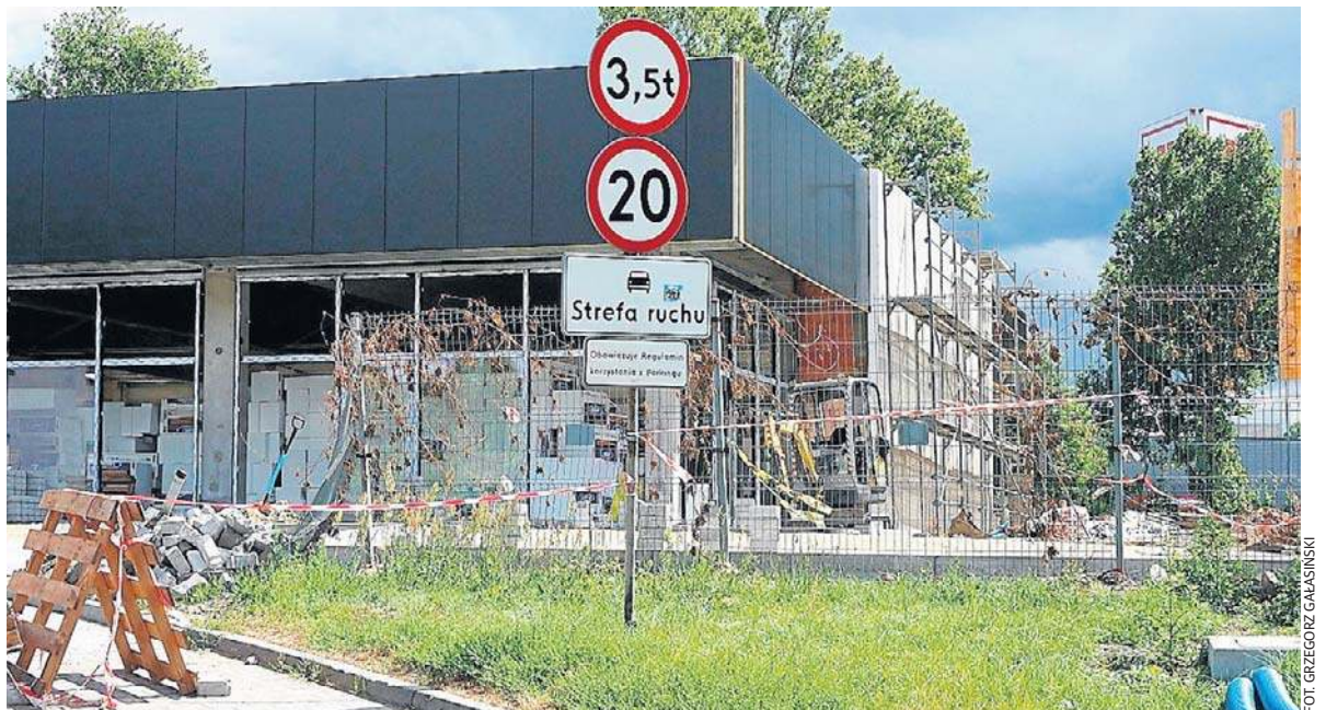
Oba budynki już stoją, trwają prace wykończeniowe, które mają zakończyć się pod koniec sierpnia.
