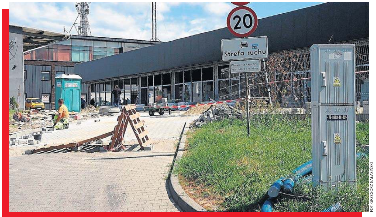
W większym budowanym budynku ma być 8 lokali, w mniejszym jeden.
