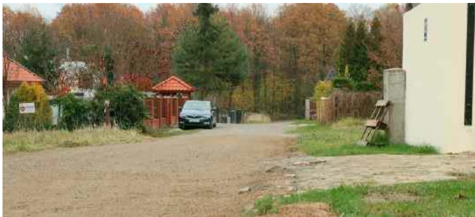
Część mieszkańców ul. Bażantowej obawia się, że wyasfaltowanie jezdni bez budowy kanalizacji burzowej doprowadzi do zalewania ich posesji
