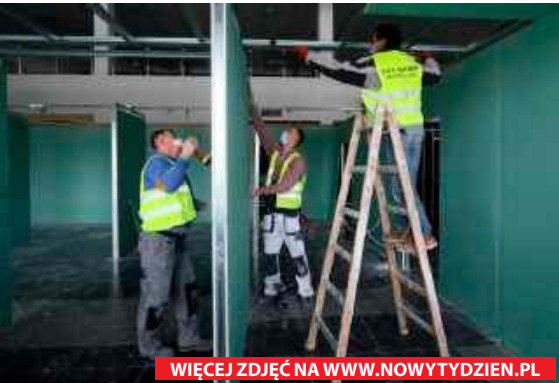
Budowa szpitala tymczasowego w Lublinie
