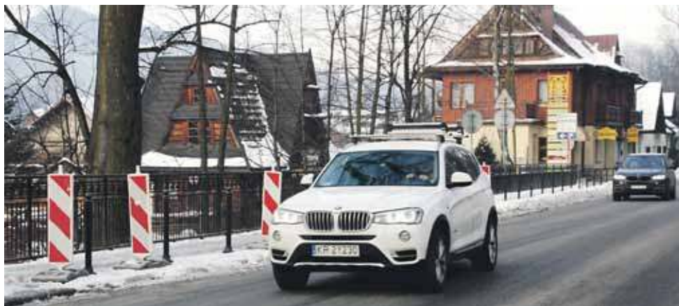
Pierwsze słupki przy ulicy Główniej w Szczawnicy już są, niebawem będą kolejne.
