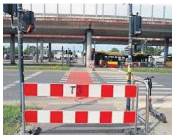
Wiadukt w remoncie
