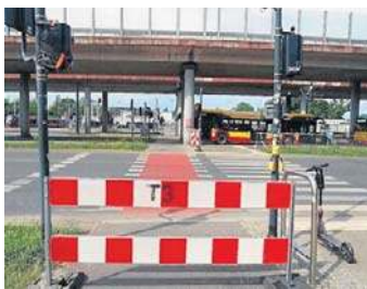
Wiadukt w remoncie
