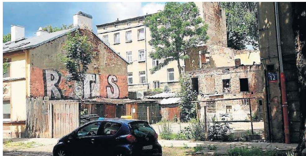
Okolice Wodnego Rynku to mieszanka nowych bloków i starych ruder oraz pustych placów po wyburzonych budynkach. Remonty ulic to początek zmian na tym obszarze
