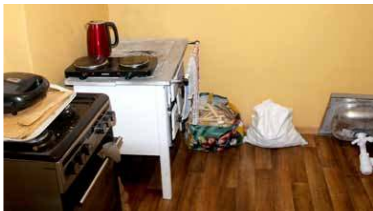
Piec nie jest podłączony do komina. Natomiast kuchenka nie ma podłączenia do gazu. Dopiero na dniach została dostarczona butla
