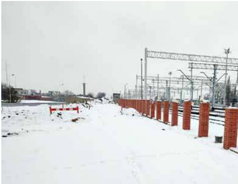
Na placu budowy widać już elementy ogrodzenia
