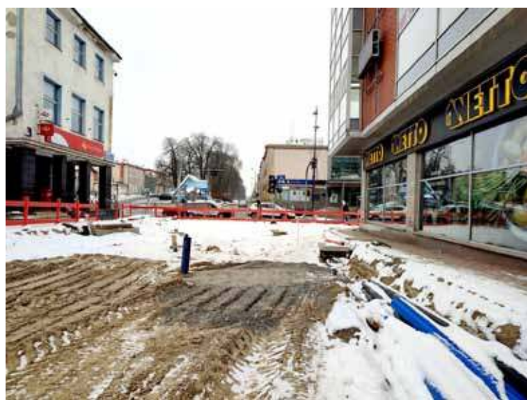
Zakończyli się prace związane z przebudową kanalizacji deszczowej
