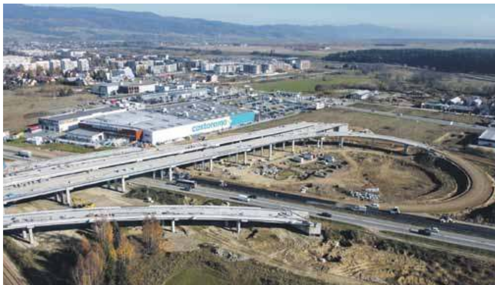
Tak dziś wygląda budowa węzła Nowy Targ - Południe.
