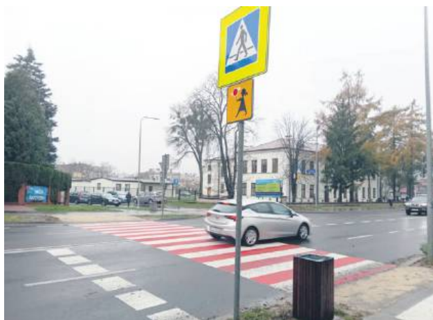
Przejście wróciło na stare miejsce.
