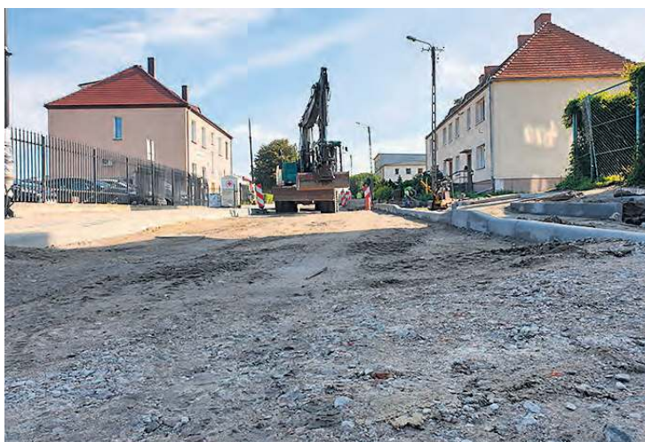
Na ul. Karasiewicza w Tucholi od wielu tygodni trwa gruntowny remont. Fot. (mac)
