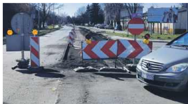
Prace przy remoncie kanalizacji sanitarnej na ul. Oławskiej musiały być przeprowadzone jeszcze przed wejściem ekipy drogowców
