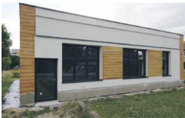
Tak wygląda elewacja frontowej ściany świetlicy w budynku po byłym sklepie. Fot. UMiG Strzelin
