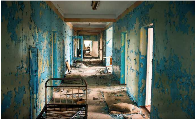
• Zniszczony szpital w mieście Wysokopilla w obwodzie chersońskim, 31 stycznia 2023 r. FOT. COLIN DELFOSSE/LEKARZE BEZ GRANIC
