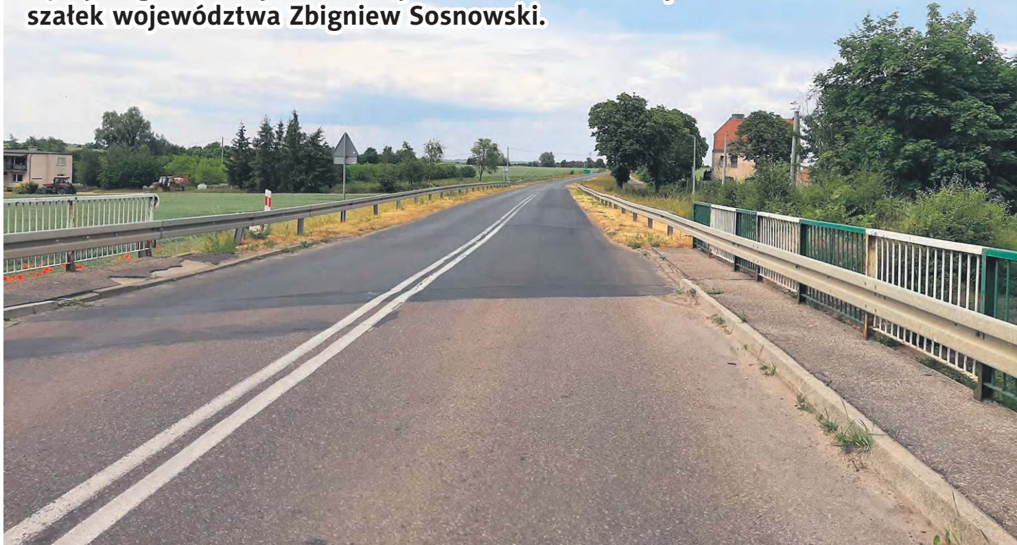
Fragment remontowanej drogi przed wjazdem do Pruszcza.
