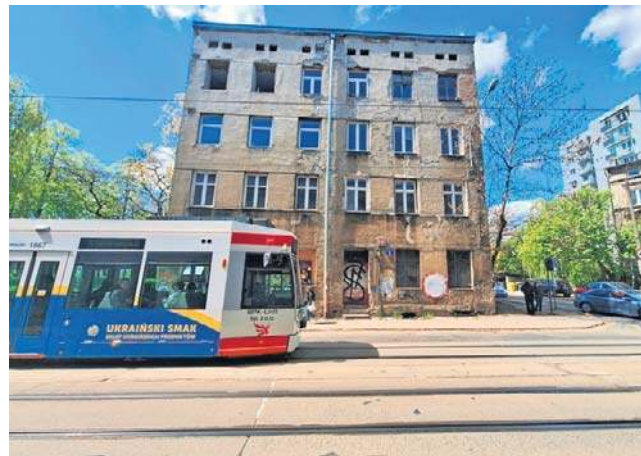
Ta kamienica przy Franciszkańskiej pod numerem 8 zostanie zburzona na samym początku prac
