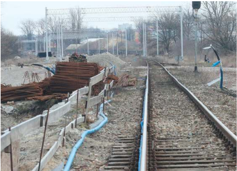
Po półrocznej przerwie modernizacja linii kolejowej Lublin-Dęblin zostanie wznowiona
