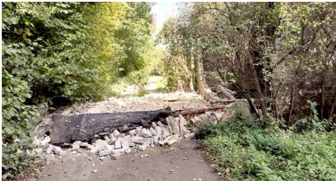
W miejscowości Mariankowo ściana stodoły zawaliła się na drogę. Foto. OSP. Marianowo
