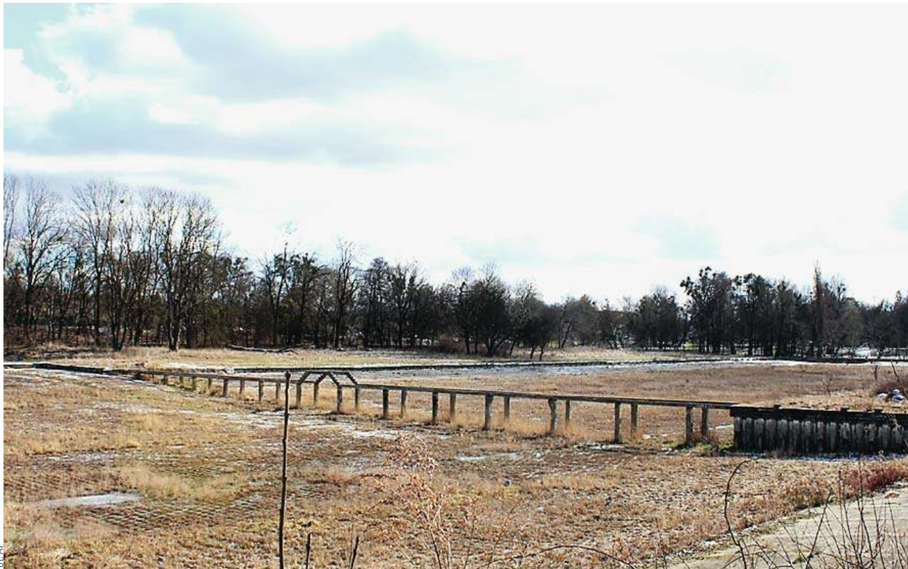
Basen przy ul. Spacerowej został zamknięty w 2012 r. po interwencji sanepidu w sprawie zanieczyszczonej wody. Od tamtego czasu obiekt niszczeje
