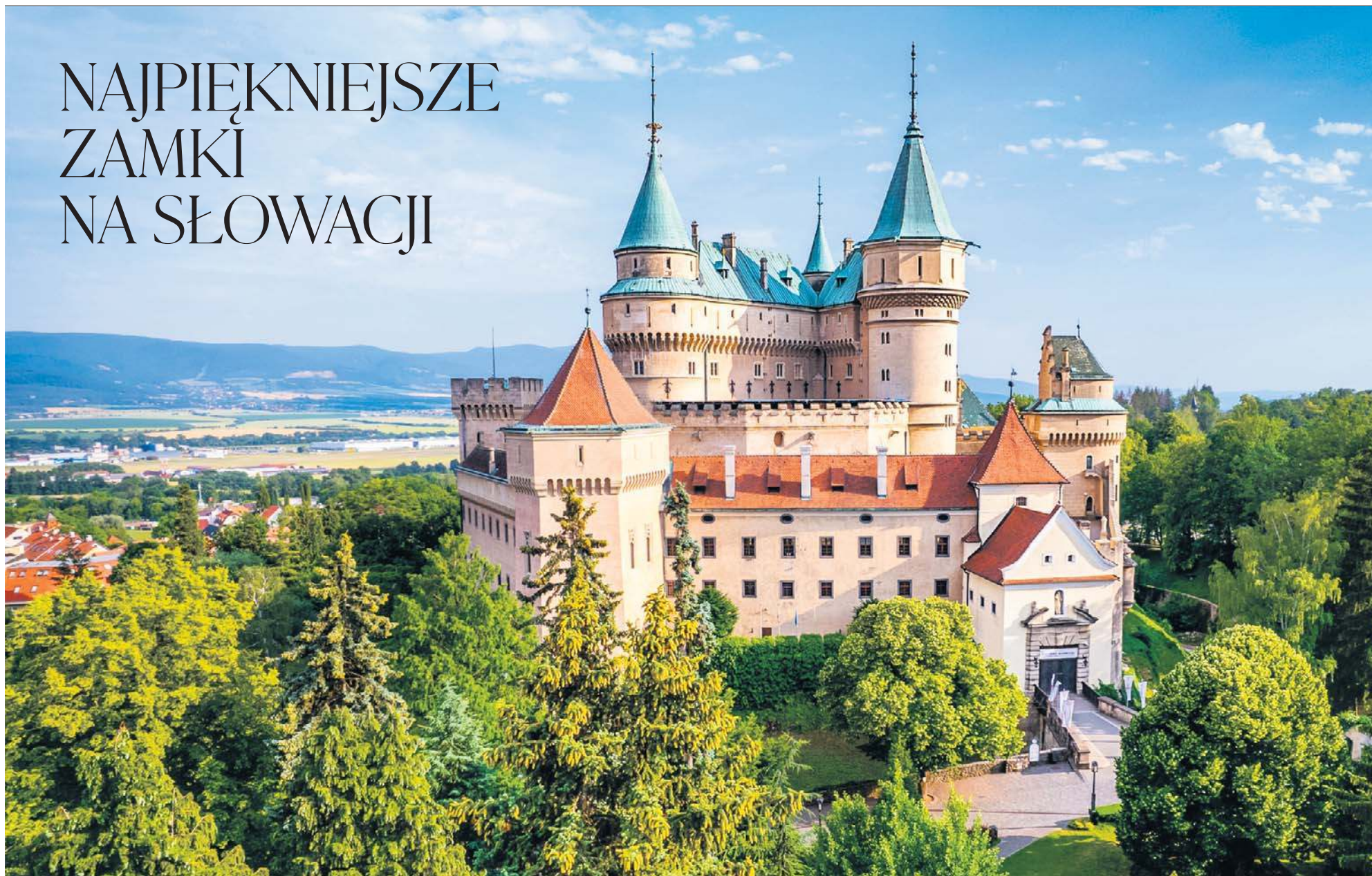
Zamek w Bojniciach to być może najpiękniejszy słowacki zamek – przypomina bajkowe budowle z filmów Disneya
