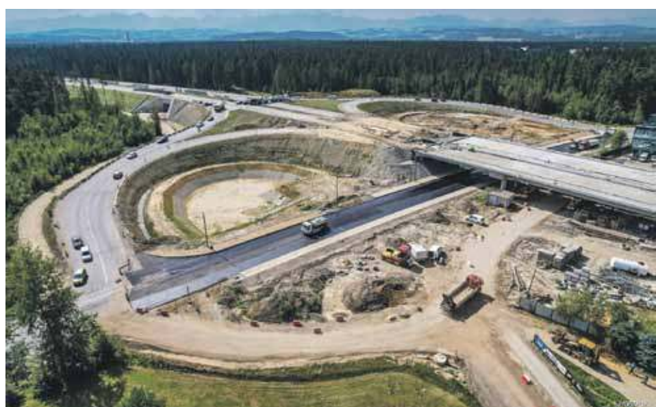
Postępują prace przy budowie węzła Nowy Targ Zachód.
