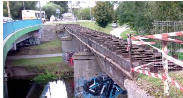
Most kolejki został oczyszczony z reszek drewna
