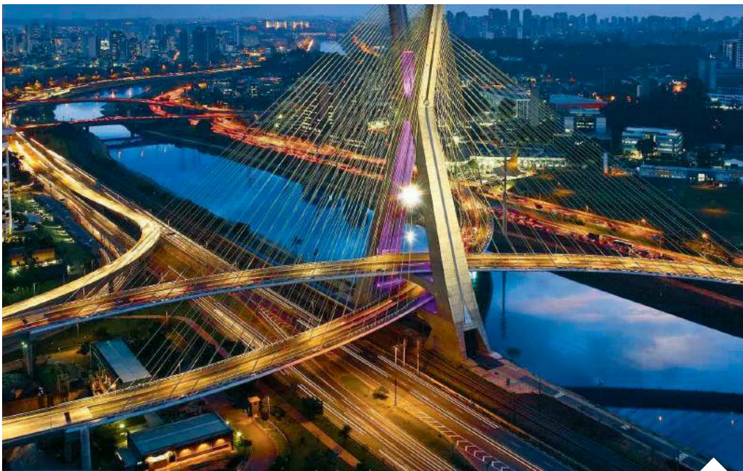
Most Ponte Octávio Frias de Oliveira | fot. Wikipedia/d
