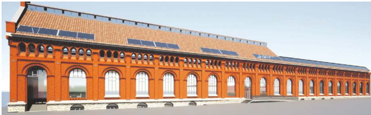
Tak zmodernizowany budynek siłowni będzie się prezentował z zewnątrz
