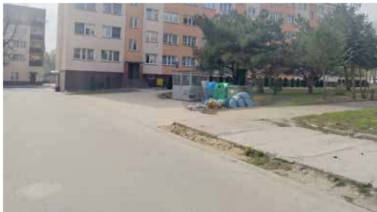
Po stronie miasta wraz z remontem nastąpiła niwelacja terenu, z kolei na terenie spółdzielni dalej straszą płyty
