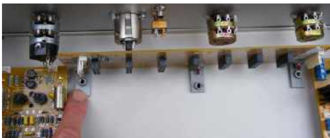
Rysunek 19. Montaż płyty głównej na kątownikach
