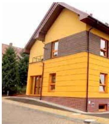
W sumie 74 tys. zł rządowego wsparcia trafiło do dwóch podmiotów realizujących na terenie Stargardu pomoc osobom bezdomnym
