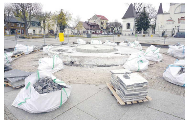
Węgrowska fontanna w budowie. fot. sej
