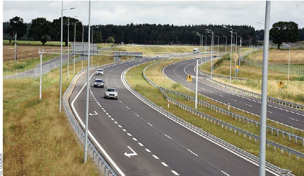
Początkiem drogi ekspresowej S5 w naszym regionie jest wybudowany już odcinek Ornowo – Wirwajdy
