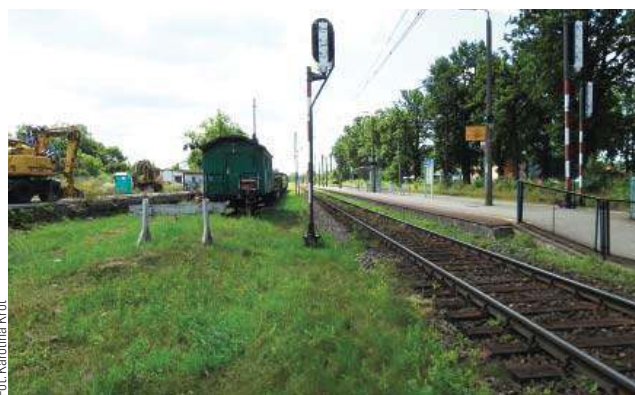
Stacja w Pasłęku zostanie przebudowana
