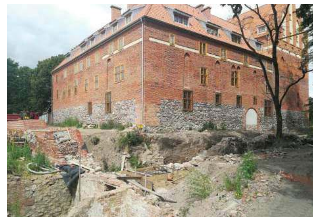
Wokół zamku wciąż trwają prace przy murach obronnych
