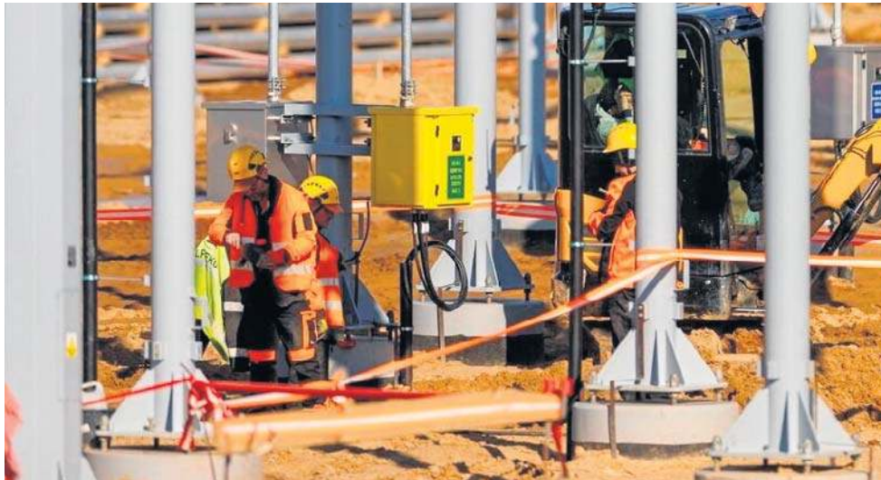
Stacja elektroenergetyczna Choczewo na ostatnim etapie budowy
