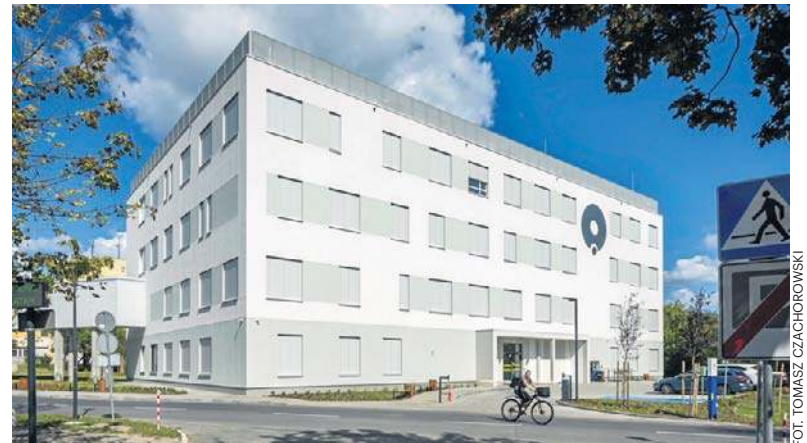
Centrum na terenie kompleksu szpitalnego, od strony ul. Ujejskiego
